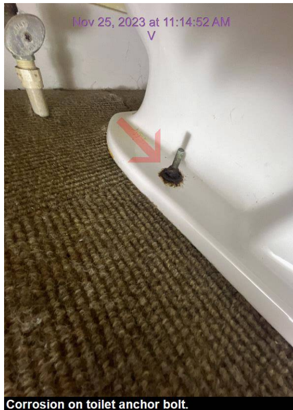
Corrosion on toilet anchor bolt.
